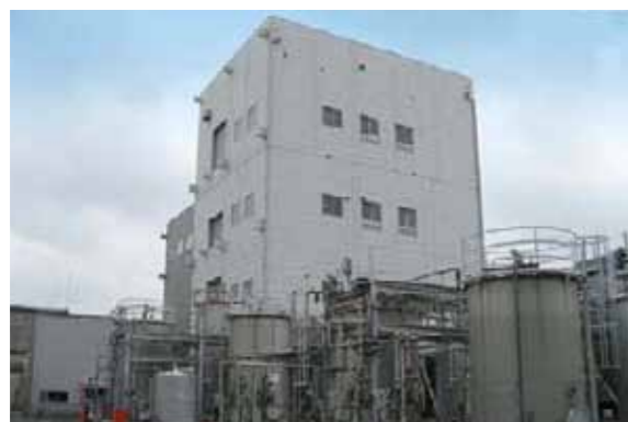
原薬製造エリア API production area
