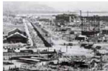
転用前の光工場(旧海軍工廠跡) Plant site prior to conversion (Navy arsenal)
