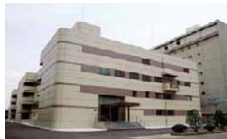
大阪工場 Osaka Plant
