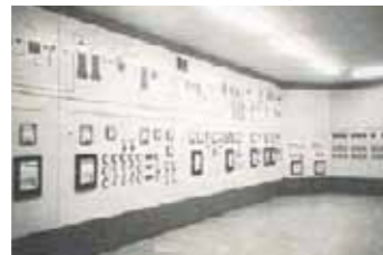
光工場初の中央計器室 The plant's first Central Control Room
