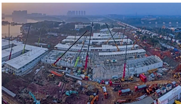
Ilustración 5 - Hospital Huoshenshan en proceso de construcción
